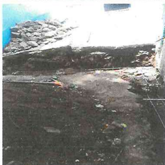
Foto 1: Fundición de zapata
