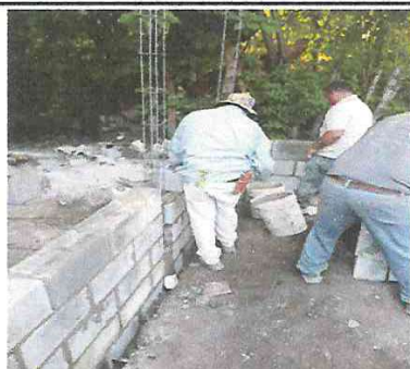
Foto 3: Levantado de paredes
