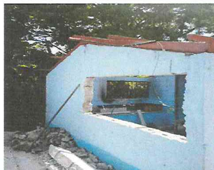
Foto 4: Abertura para instalación de balcon de metal y ventana de PVC.
