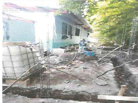
Foto 2: Colocación de columnas y fundición
